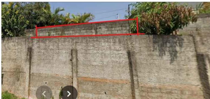
VISTA FRONTAL DO MURO ANTES DE COLAPSAR - Fonte GOOGLE MAPS
