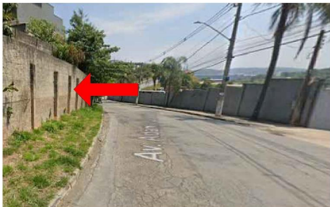
VISTA DE MONTANTE DO MURO ANTES DE COLAPSAR - Fonte GOOGLE MAPS
