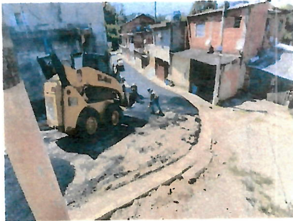
FOTO 02 e 03: APLICAÇÃO DE REVESTIMENTO DE CONCRETO ASFÁLTICO
