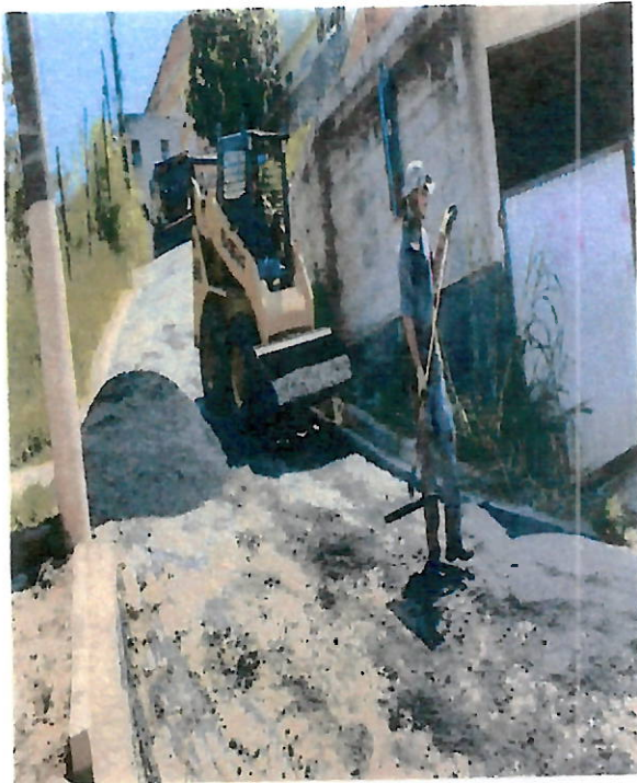
FOTO 01 - APLICAÇÃO DE REVESTIMENTO DE CONCRETO ASFÁLTICO
