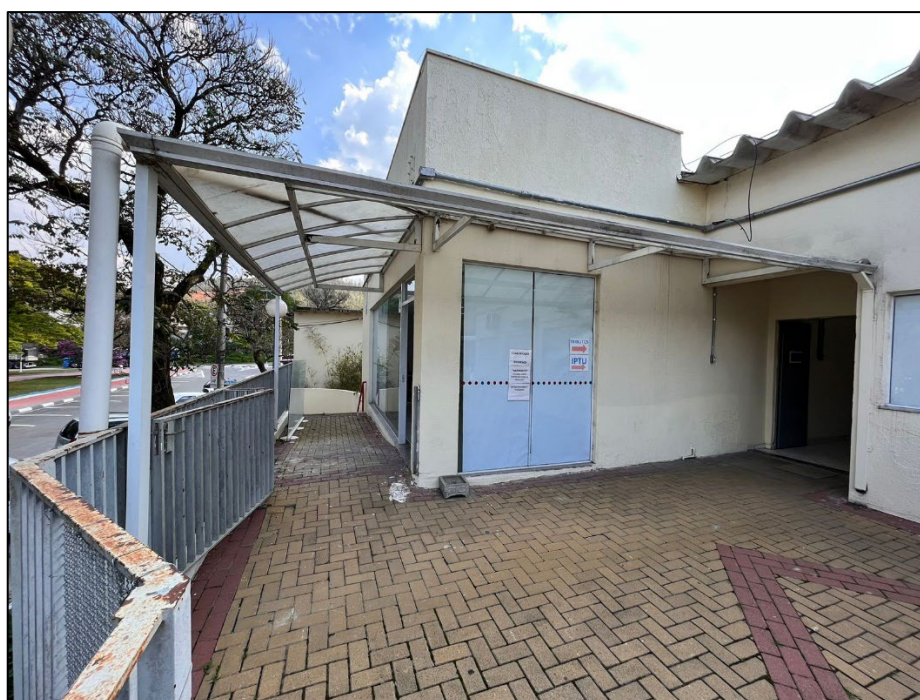
Figura 4 - Localização do espaço comercial no prédio
