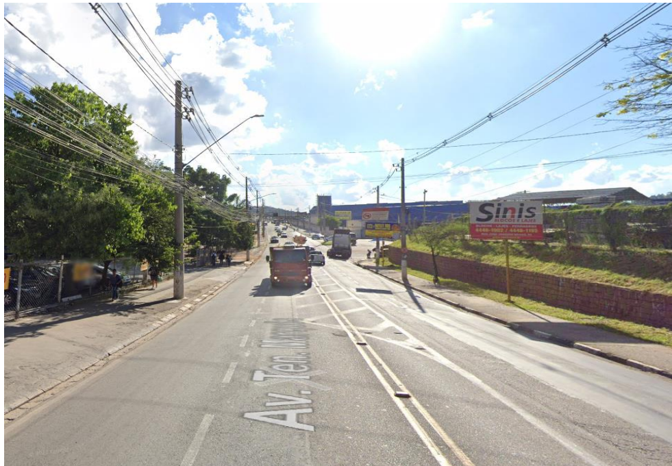
Figura 37 – Características da Av. Tenente Marques – Sentido Oeste (Fonte: Google Street View, março/2021)
