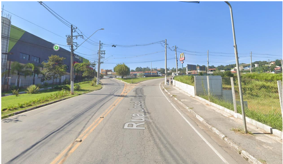
Figura 2 – Características da Rua José Marques Ribeiro – Sentido rotatória da Av. Tenente Marques (Fonte: Google Street View, março/2021)
