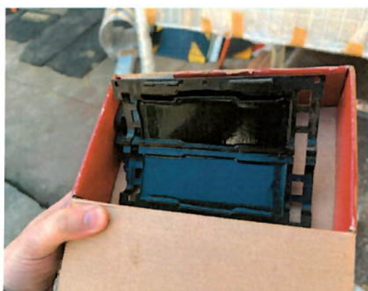
EMENDA DE CABEAMENTO
